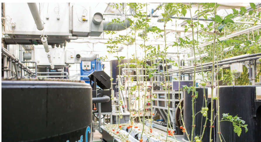
Hydroponická část s rajčaty je napájena vodou obohacenou živinami z vedle stojících plastových nádrží s rybami. Experimentální akvaponický skleník ve výzkumném ústavu Leibniz Institute of Freshwater Ecology and Inland Fisheries (IGB), Berlín
