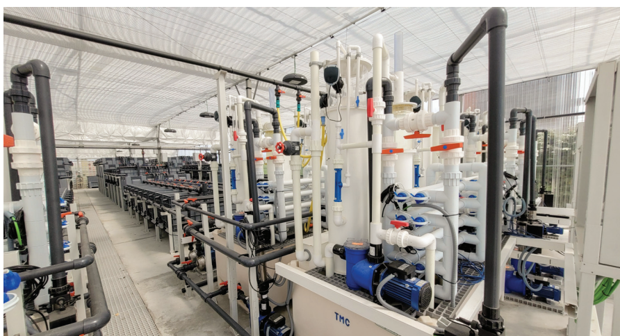
Ukázka technologické komplexnosti akvaponického systému zahrnující soustavy čerpadel, ventilů, provzdušňování a dalších technologických prvků pro oběh a průběžnou úpravu kvality vody. Univerzita Aveiro, Portugalsko
